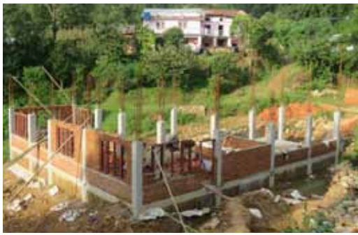
Bethel Restoration Center i Nepal byggs nu i snabb takt.
