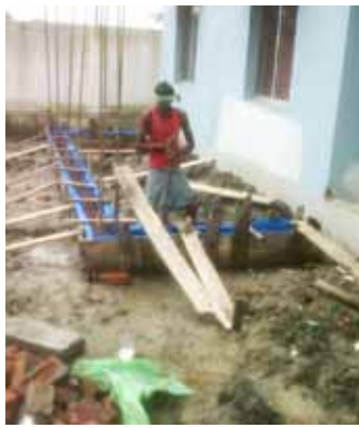
Arbete med trappan upp till övervåningen på centret i Kolkata.
