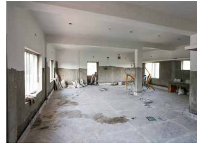
Invändigt arbete på övervåningen fortsätter.
