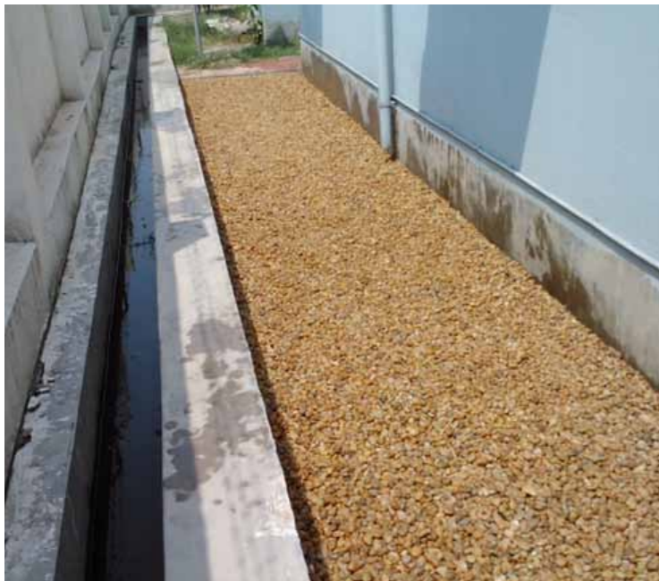
Ogräs rensas bort och öppna ytor mellan husen fylls med småsten.
