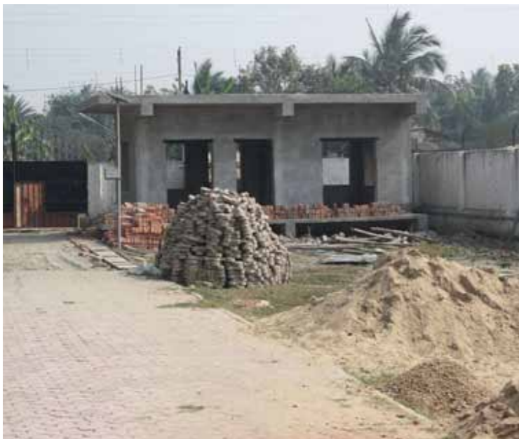
Vaktmästarbostad och förråd växer fram.
