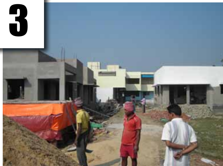
Bygge av gästhus och kontor i februari 2013.
