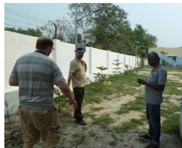
Bygginnspektion med byggmästaren Subro.
