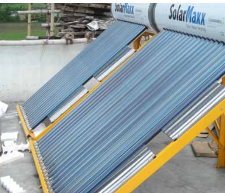
Solceller installeras på taket juli 2012.
