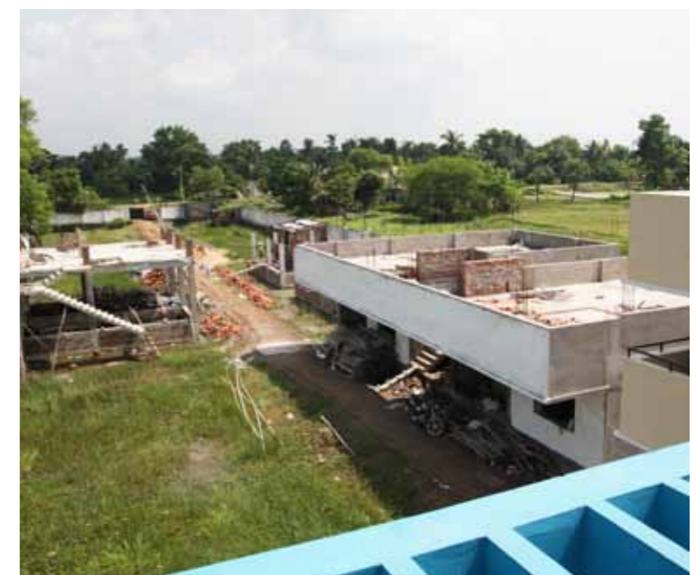
Utsikt från taket oktober 2012.
