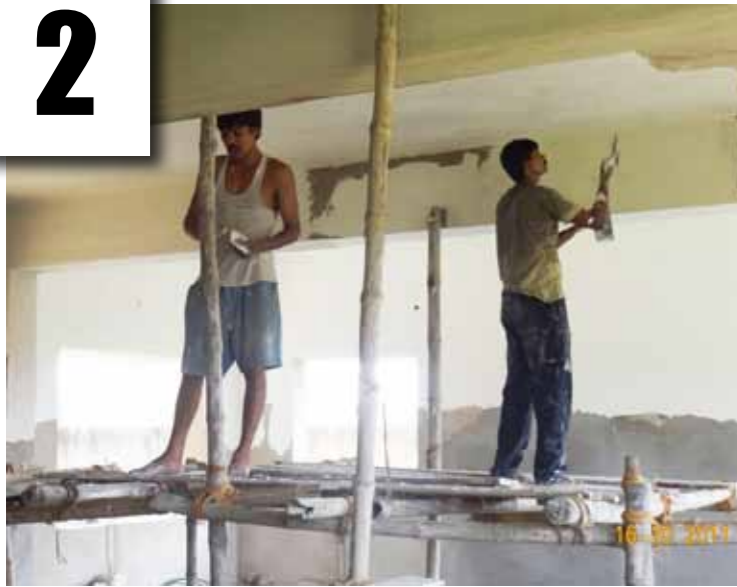
Mycket arbete pågår även invändigt i husen.
