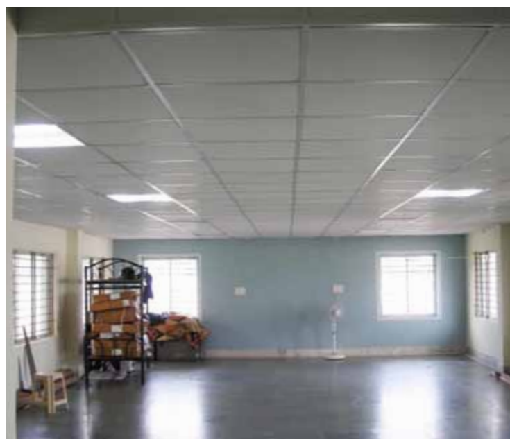
Innertak och golv på plats i samlingslokalen.
