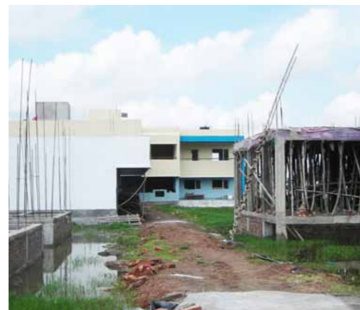
Volontärbyggnad och föreståndarbostad byggs.
