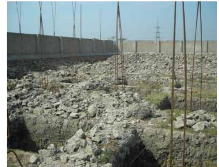
Här gjuts grundpelarna till Hus 1, februari 2011
