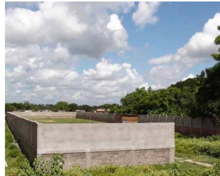
Muren är klar juni 2010.
