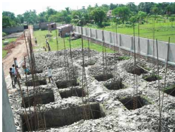
Grunden till Hus 3 påbörjad i juli 2011
