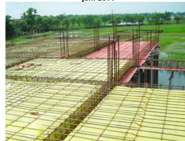
Armering av golvet/taket innan nästa plan byggs.
